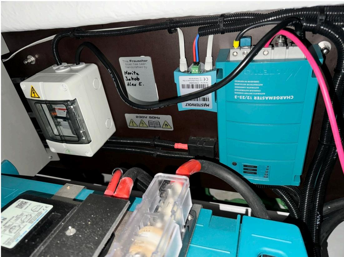
Abb.#9: Landanschluss, FI und Ladegerät
