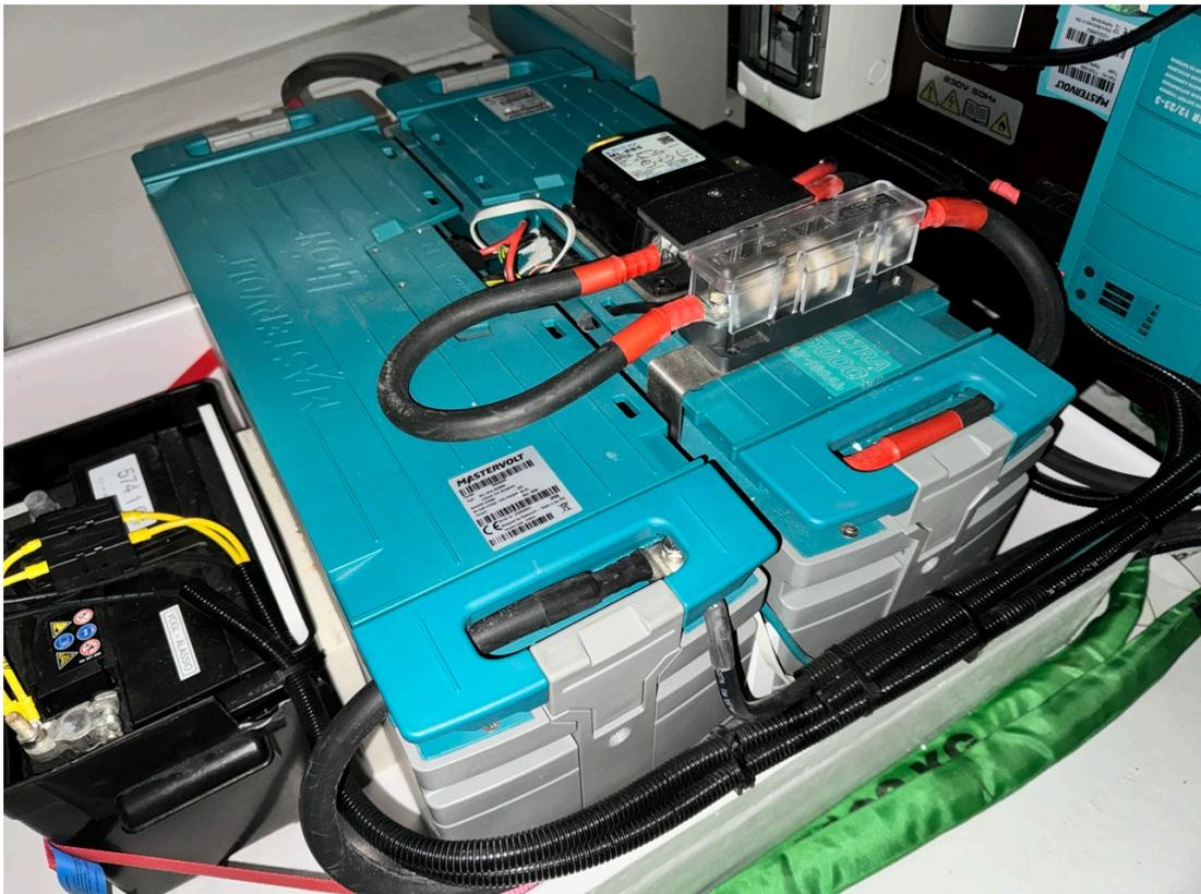
Abb.#8: Mastervolt 24/5000 LiFePo Batterien
