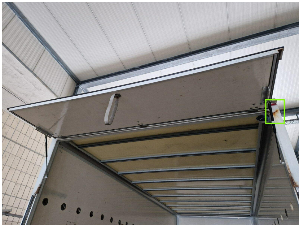
Bild 18 : Eckrunge hinten rechts gerissen
