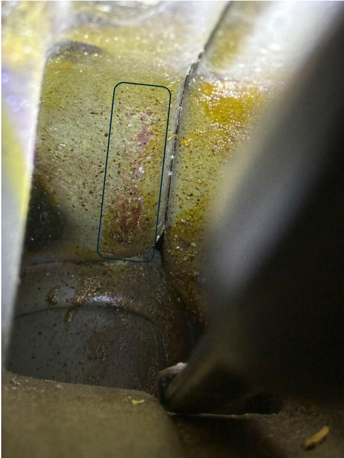
Die Fahrgestellnummernprägung Innenansicht Längsträger vorne rechts
