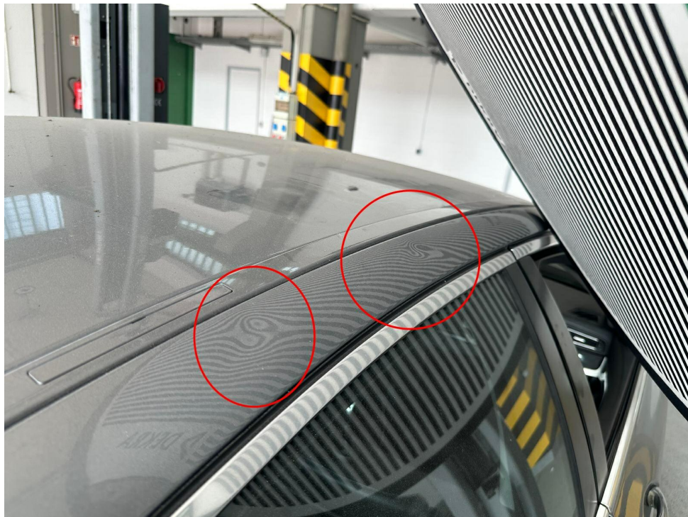
Bild 11 : Dachrahmen rechts mehrfach eingedellt
