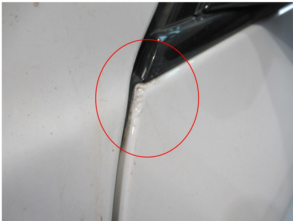
Bild 22 : Tür vorne links korrodiert
