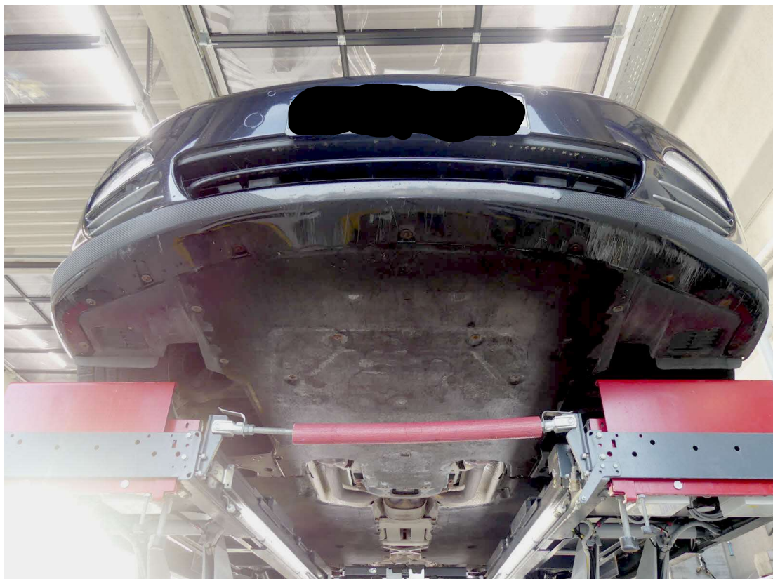
Bild Nr: 12 Unterboden vorne
