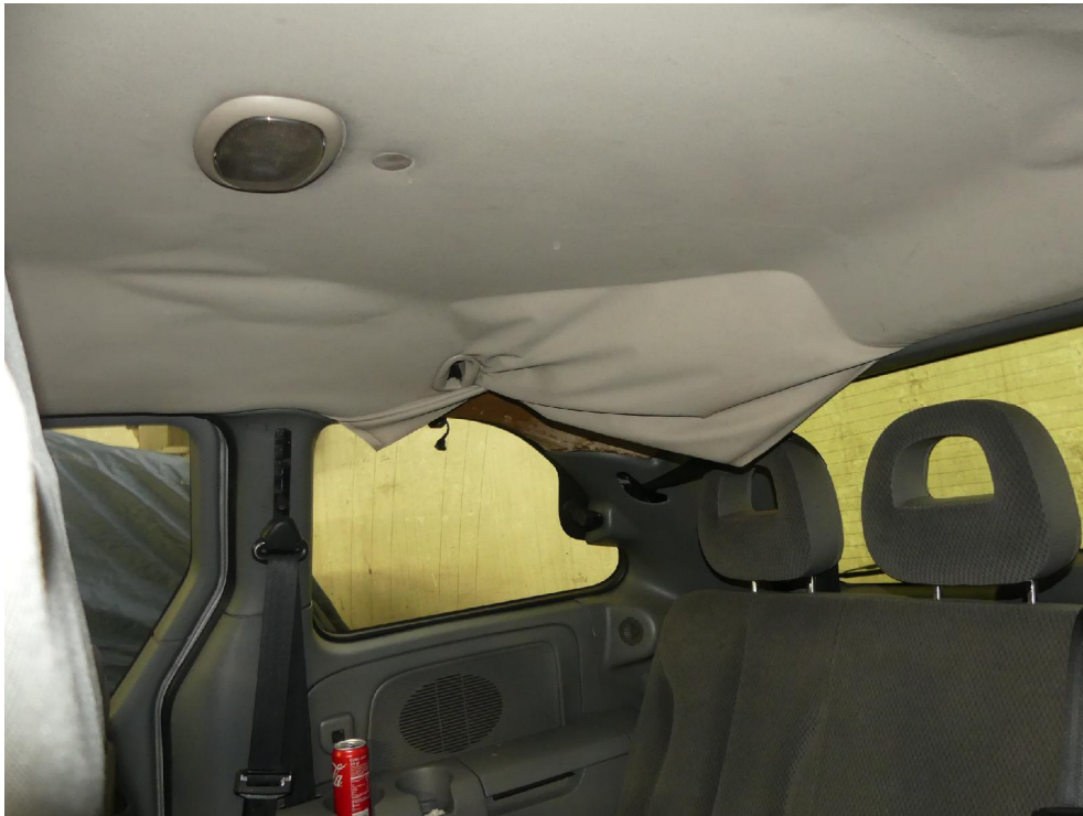
Bild: 21 Detailansicht Innenhimmel.
