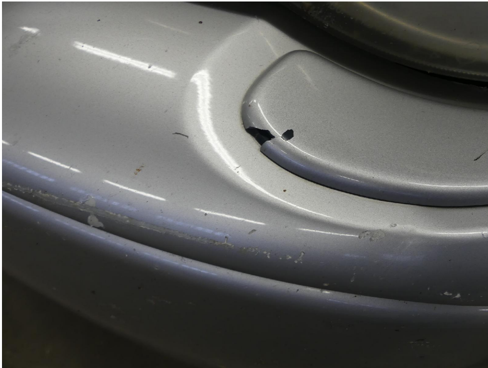
Bild: 47 Abdeckung SWA partiell ausgebrochen.
