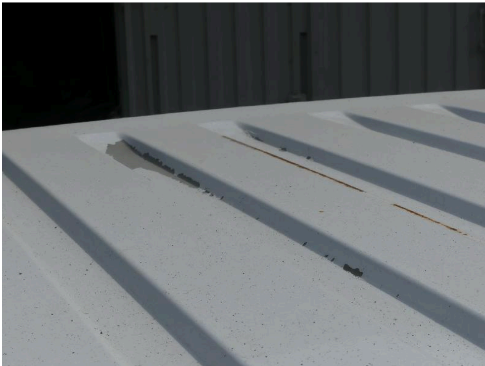
Bild: 35 Weitere Bereich des Fahrzeugdaches weisen Ablösung Lackmaterial auf.
