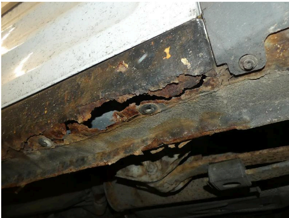
Bild: 46 Detailansicht Durchrostung Einstiegsschweller links
