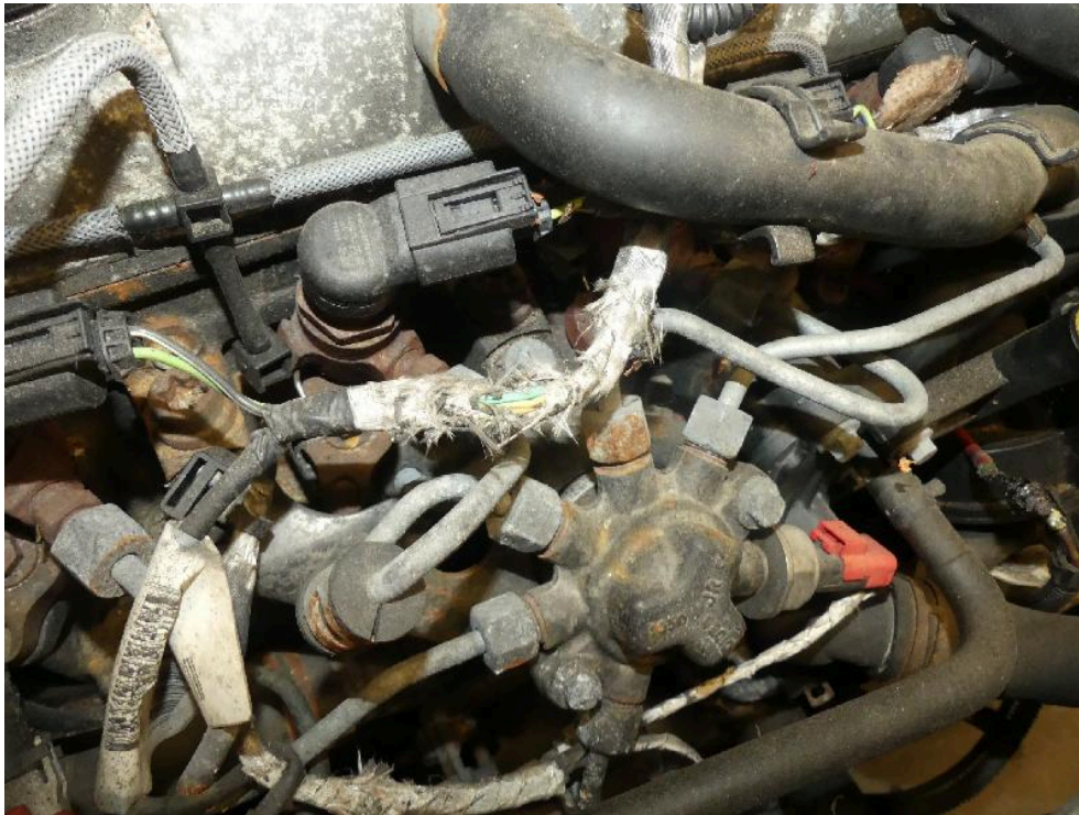
Bild: 31 Detailansicht, Beschädigung Leitungssatz vorhanden.
