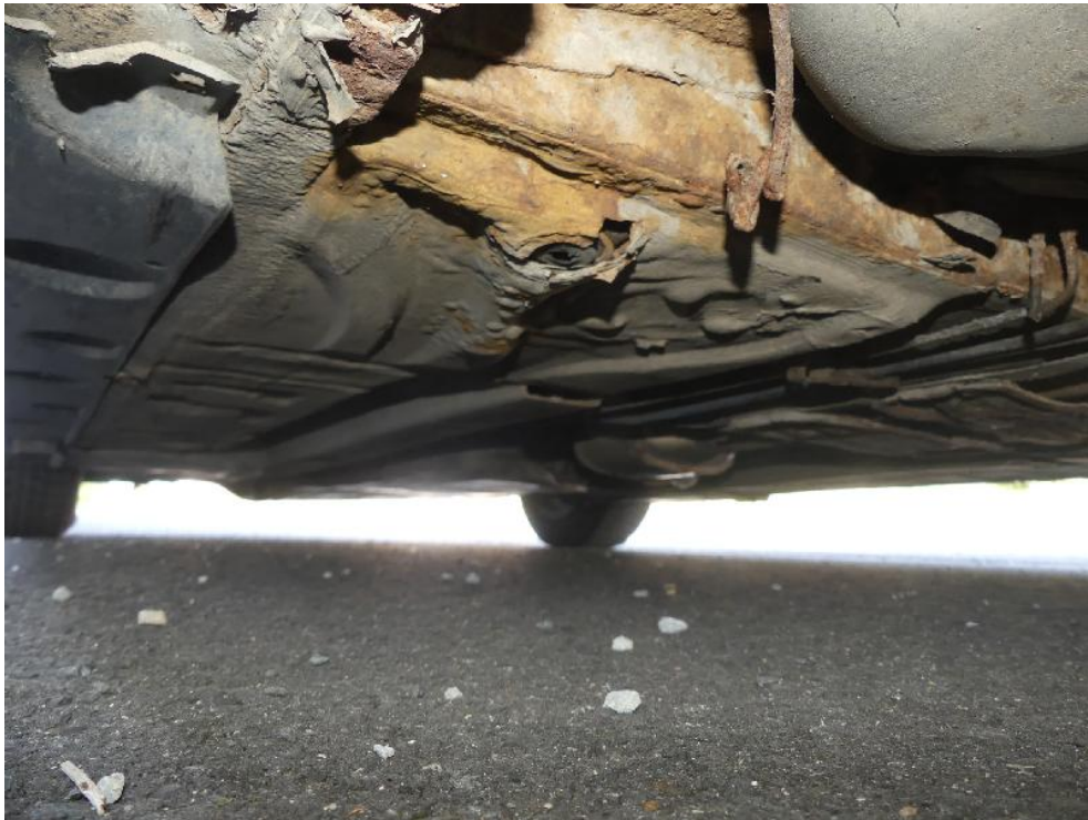
Bild: 69 Ansicht Unterboden
