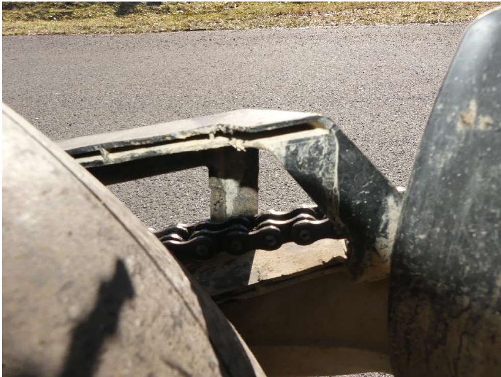
Bild: 33 Abdeckung Antriebskette partiell abgetragen.
