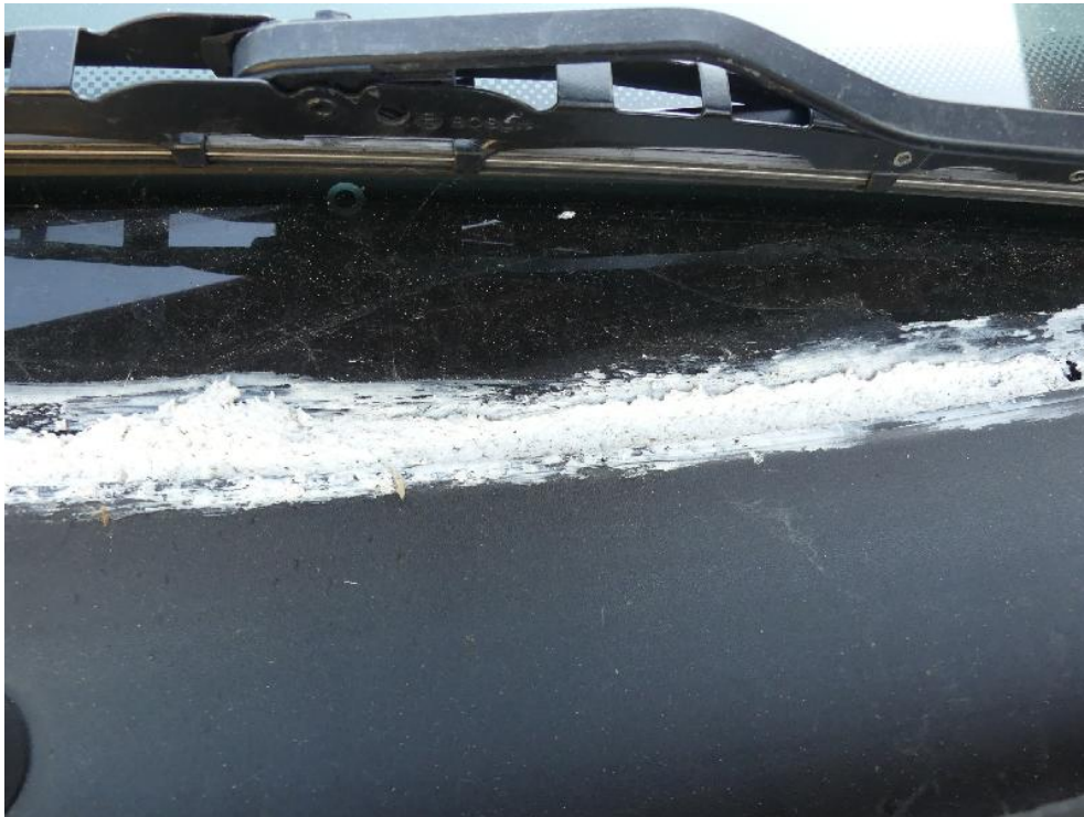
Bild: 53 Abdichtung Frontscheibe nicht fachgerecht.
