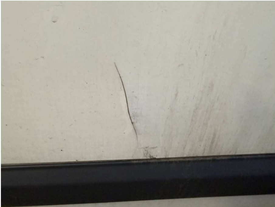
Spachtelauftrag linke Seitenwand
