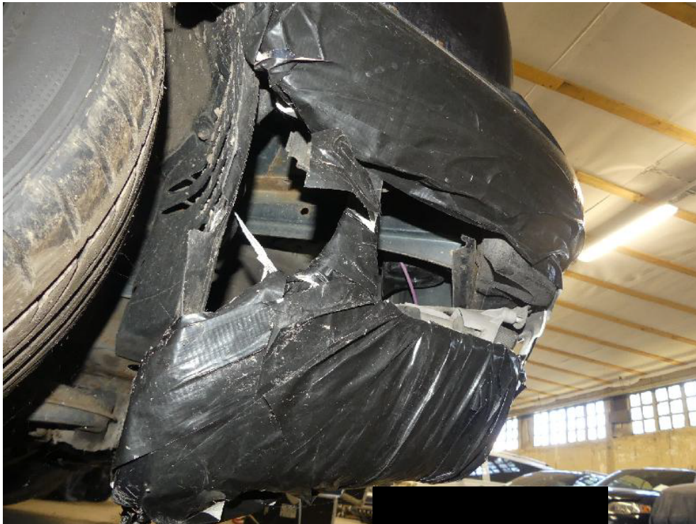
Bild: 43 .... diese ist großflächig ausgebrochen / zerstört.
