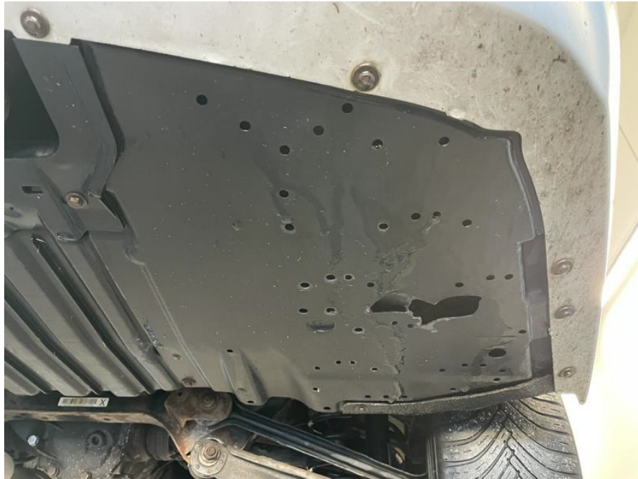
Unterbodenverkleidung hinten rechts gebrochen
