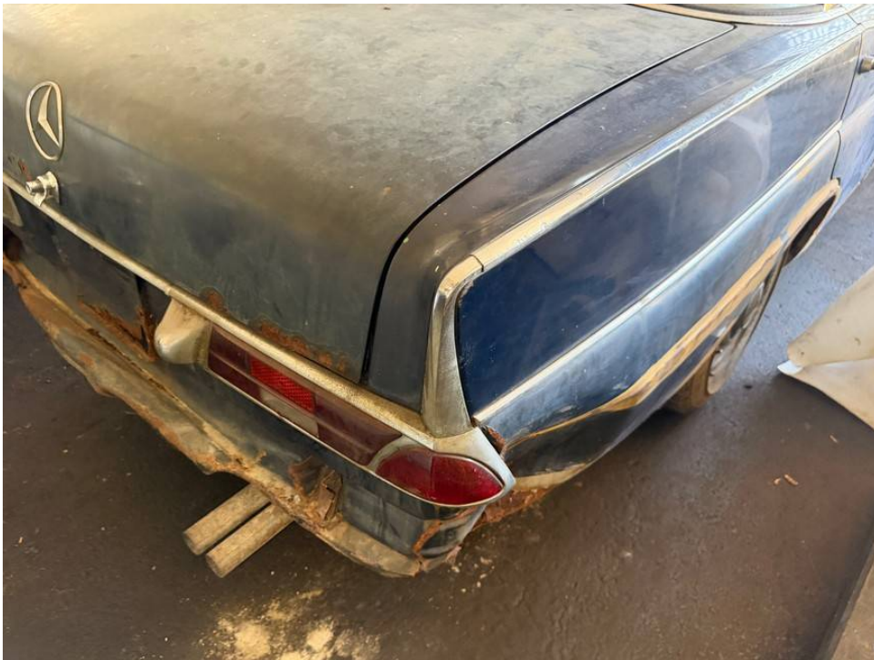
Seitenwand rechts unterhalb eingedrückt
