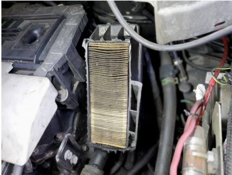
Schadenbereich : Die Abdeckung Luftfiltergehäuse fehlt
