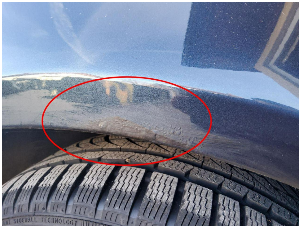
Bild 15 : Kotflügel vorne rechts, korrodiert, instandsetzen und lackieren mit Lackaufbau
