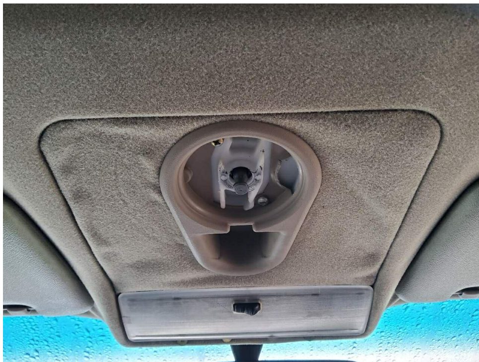
Bild 7 : Drehkurbel des Schiebedaches abgerissen
