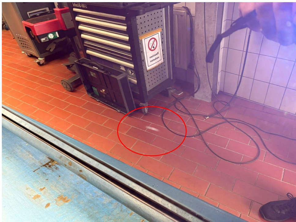
Bild 39 : Tür hinten links verschrammt
