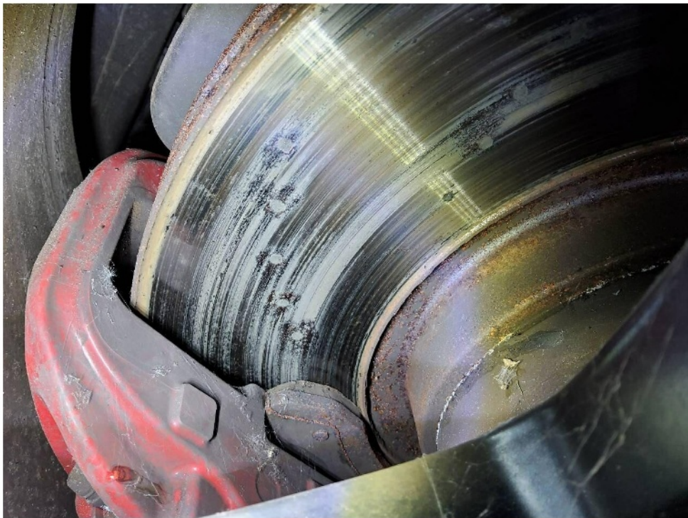
Bild 18 : Bremsen stark korrodiert
