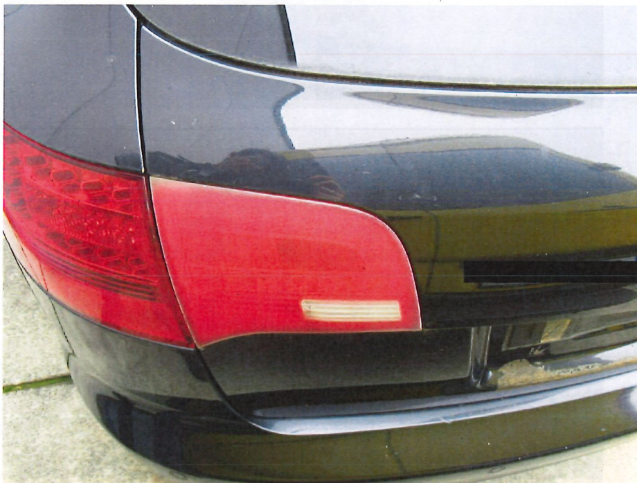
Bild 20 : Rückleuchte hinten links innen verwittert
