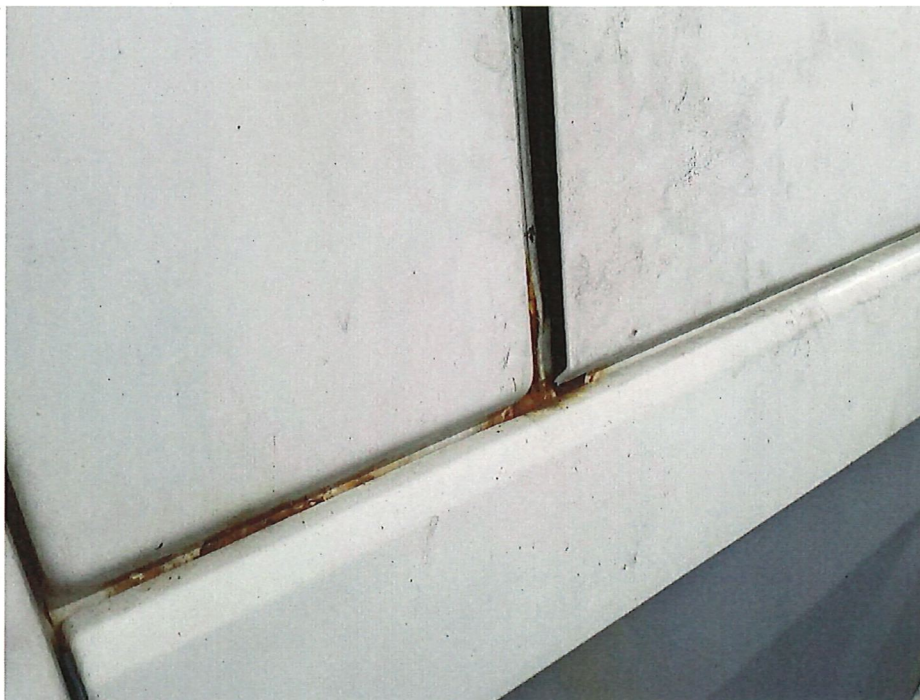
Bild 16 : Korrosion
