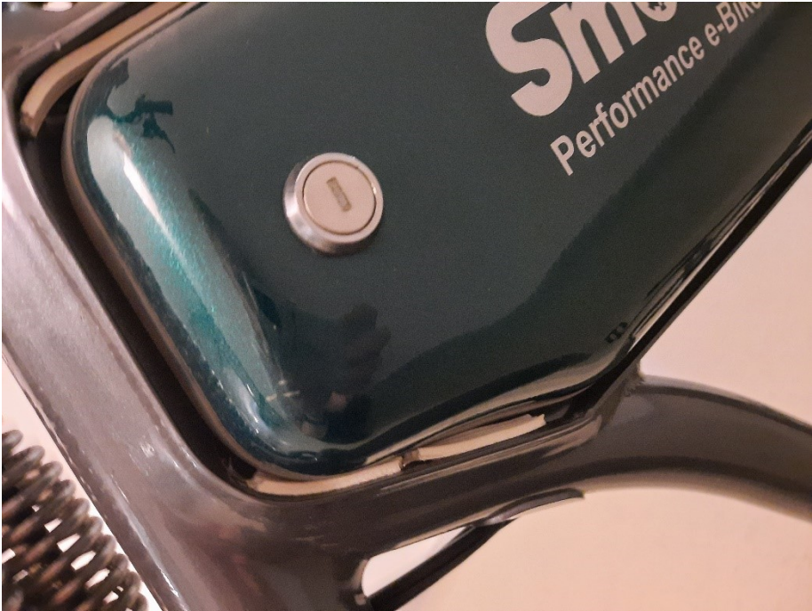
Kratzer an der linken Seite des Batteriecovers
