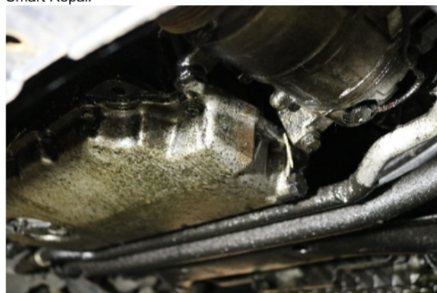
Beschädigung 5: Motor: Motor - undicht - Diagnose durchführen
