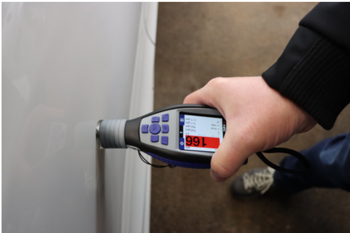
Ergebnis der Lackschichtdickenmessung Türe hi. rechts, Türe wurde beilackiert
